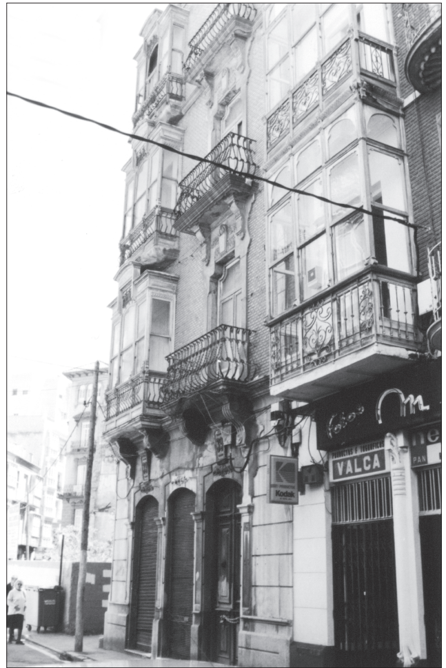
Diferentes vistas del Edificio Alessón. JAG.
